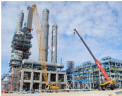
Площадка строительства Амурского газоперерабатывающего завода
