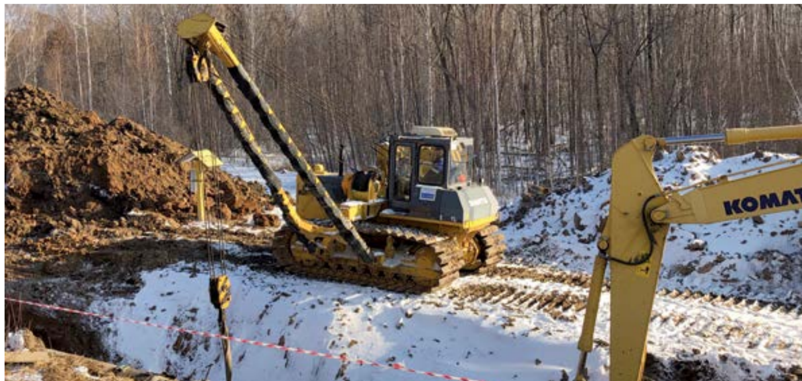
Сотрудникам Хабаровского ЛПУМГ пришлось бороться с капризами погоды, но завершающий этап работ проходил при ярком солнце
